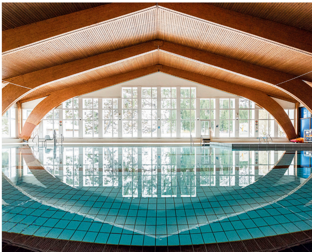
Mit den Eigentumsverhältnissen und der Sanierung des Hallenbads Ybrig beschäftigt sich ab sofort eine eigens eingesetzte Projektgruppe des Gemeinderats Unteriberg. Foto: Evelyne Marty
